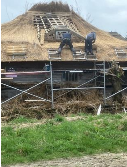
28/2, ambachtelijk werk aan het Sint Maartensrechtpad: Jan Voogt en zoon aan het rietdekken, Bruun van der Steuijt
