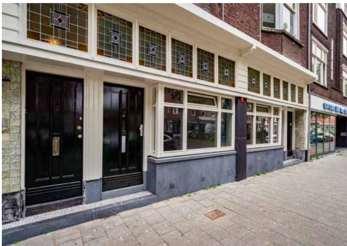
↑ Het verbouwen van winkels naar woningen is een van de instrumenten bij de aanpak van de Boulevard Zuid.
